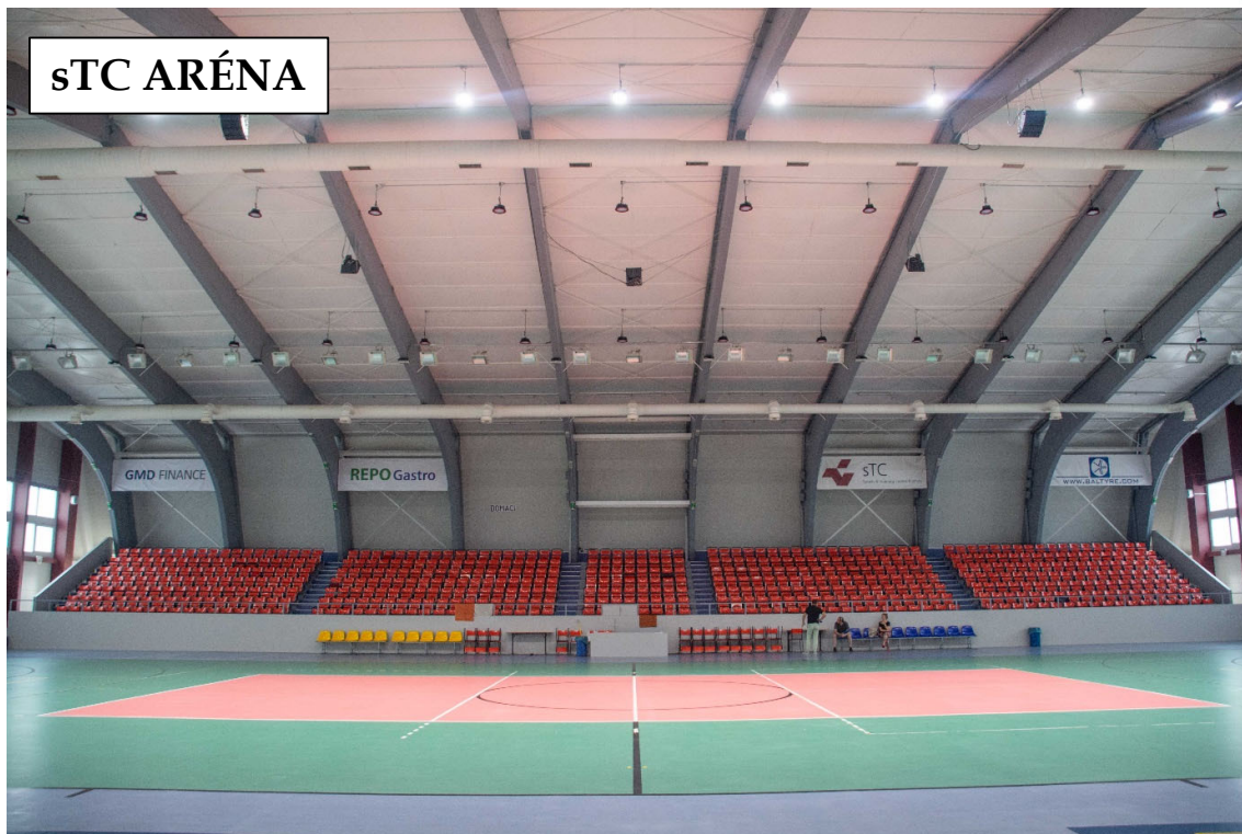
sTC FUTBALOVÁ HALA
